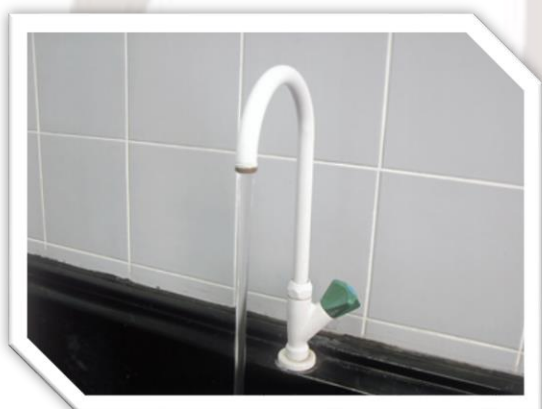
5. เปิดก๊อกน้ำให้น้ำไหลเต็มประมาณ 1 นาที เพื่อระบายน้ำที่ค้างอยู่ในท่อทิ้งไป
